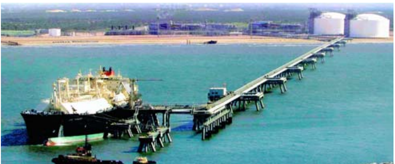
Idku LNG Plant
